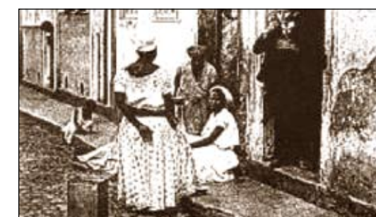
Figura 03 - Casa de vender água (SAMPAIO, 2005)
